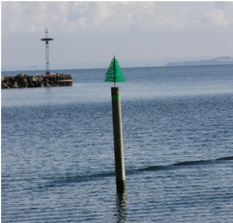
Möwen-sichere Steuerbordtonne der Hafeneinfahrt Fynshav
