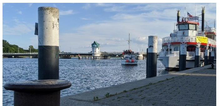
Klappbrücke in Kappeln
