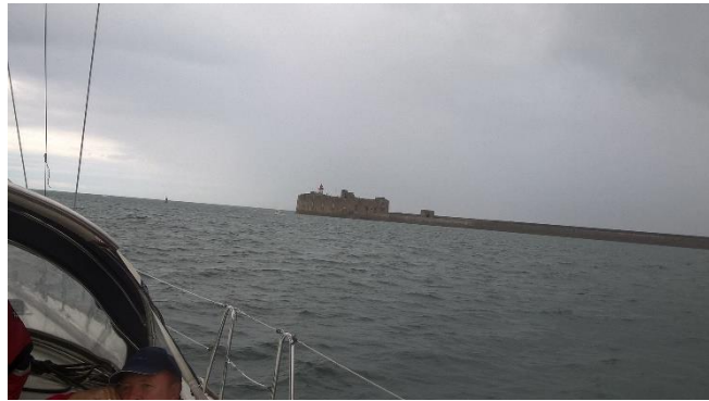
Mächtige Bewehrung: die West-Einfahrt zum riesigen Vorhafen von Cherbourg
