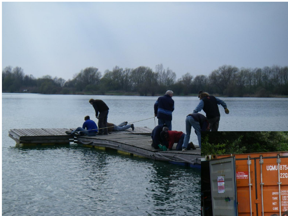
Ausbesserung des Stegs
